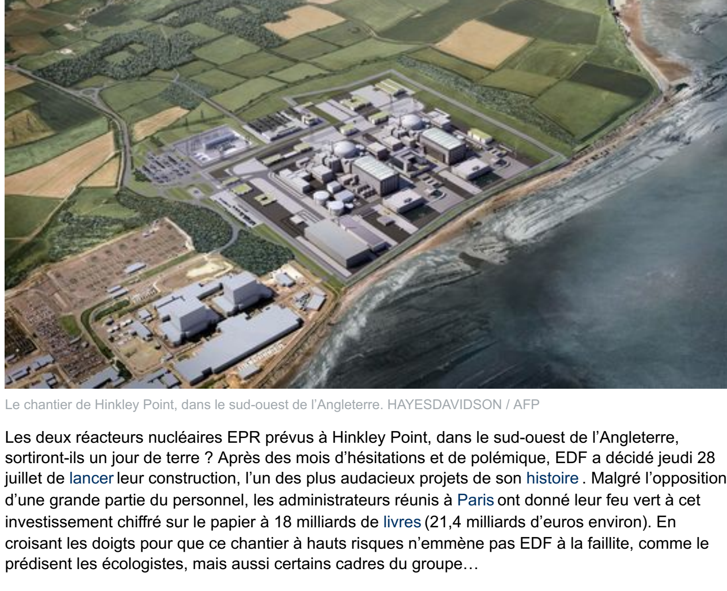
Le chantier de Hinkley Point, dans le sud-ouest de l'Angleterre. L'YVES/STAN/IGSON / AFP
