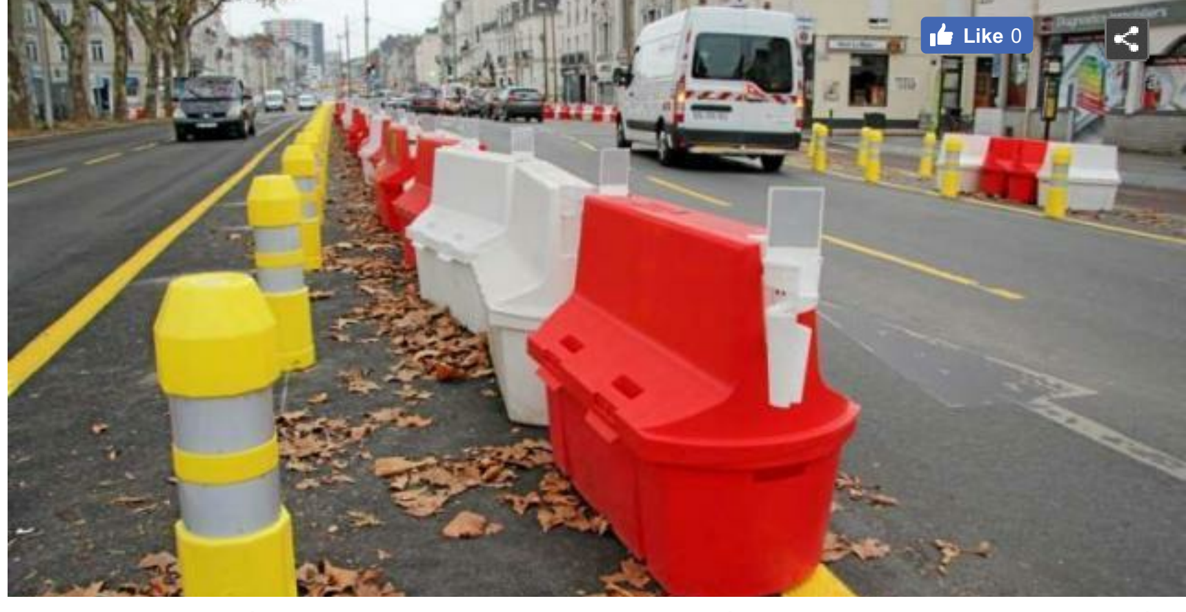
Jusqu'au vendredi 15 décembre 2017, les travaux du boulevard Ayrault, à Angers, se concentrent entre la rue Maillé et la rue Boisnet. © Ouest-France
