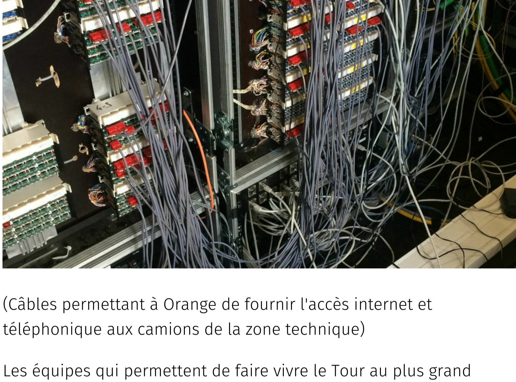
(Câbles permettant à Orange de fournir l'accès internet et téléphonique aux camions de la zone technique)
