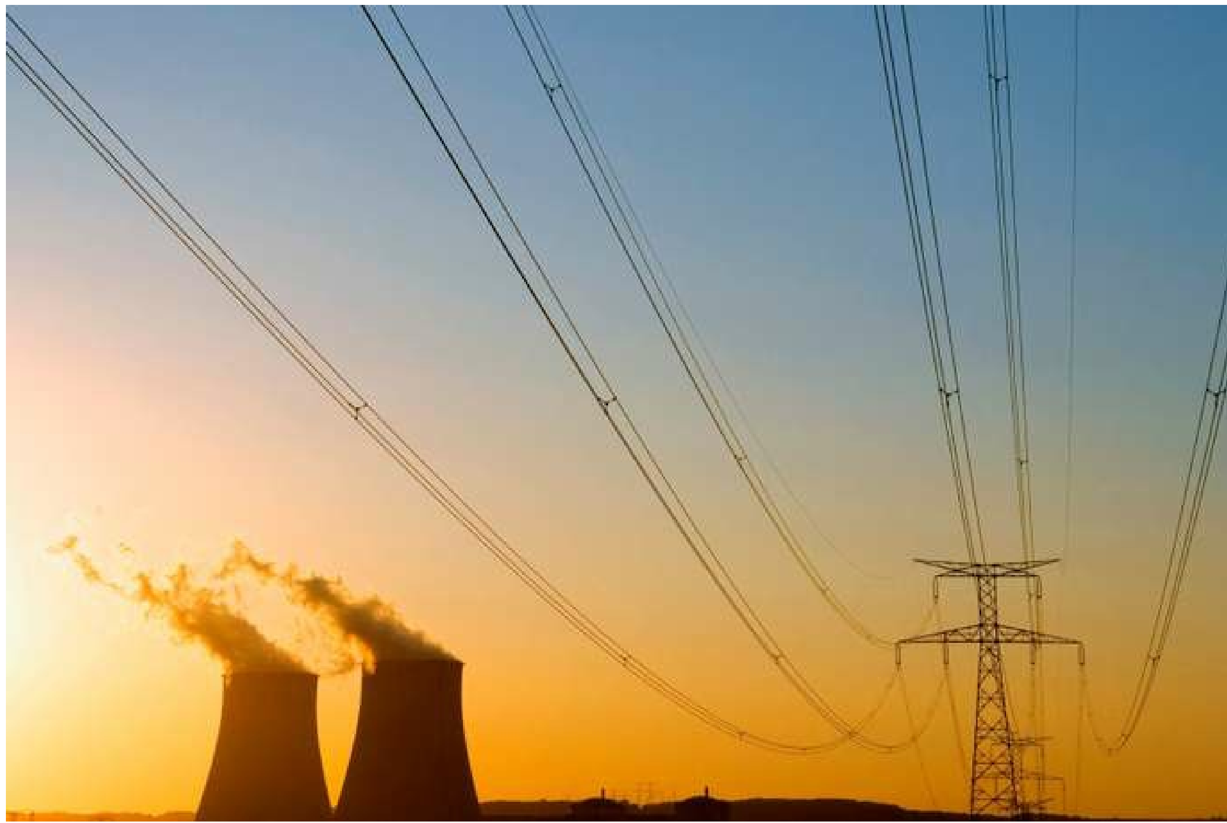
La centrale nucléaire de Nogent-sur-Seine (Aube). JAMES HARDY / PHOTOALTO / PHOTONONSTOP
