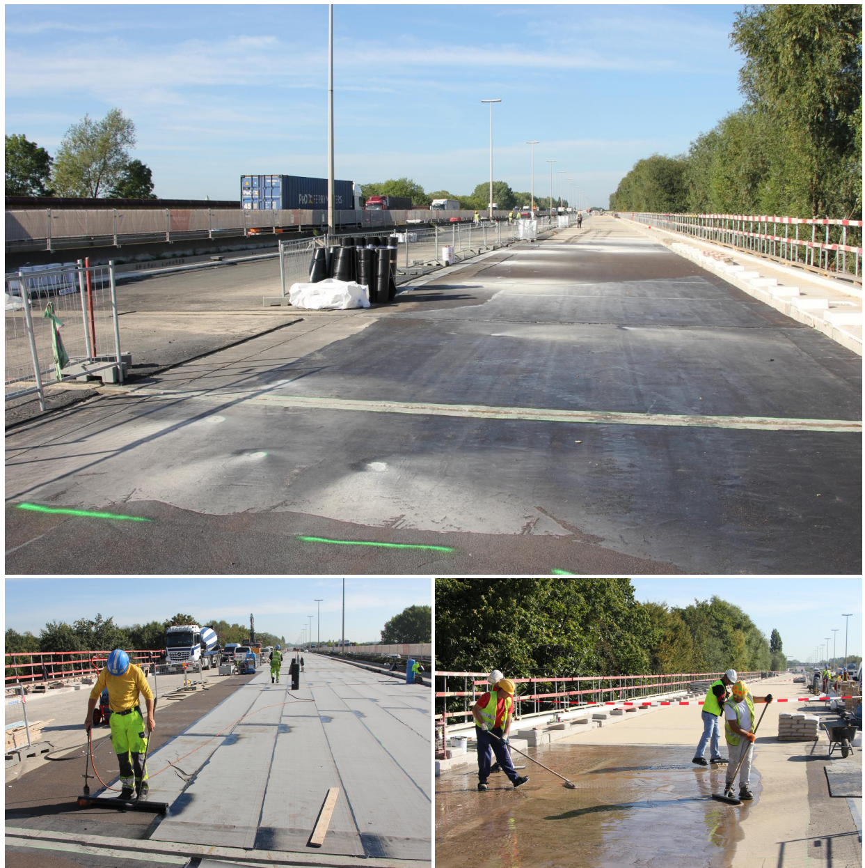
Renovatie viaduct Gentbrugge - september 2020
