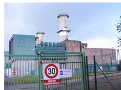
Turbines à combustion à Brennilis
