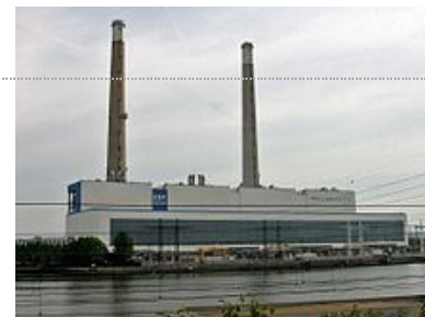
centrale thermique de Porcheville .
