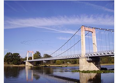
Pont suspendu franchissant la Loire et vol de grues.
