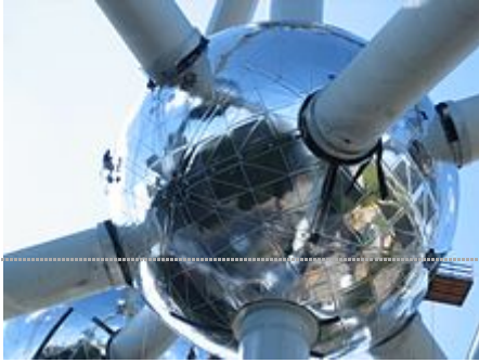
Détail de la boule centrale de l'Atomium durant sa rénovation, 2005.
