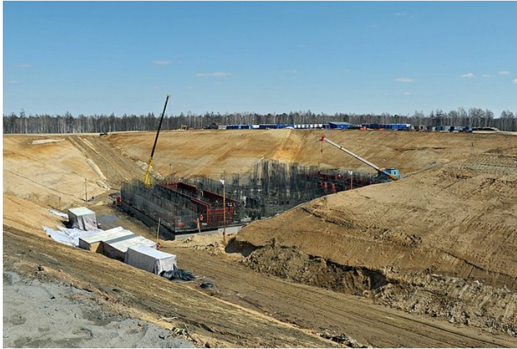
Construction du pas de tir des fusées Soyouz.
