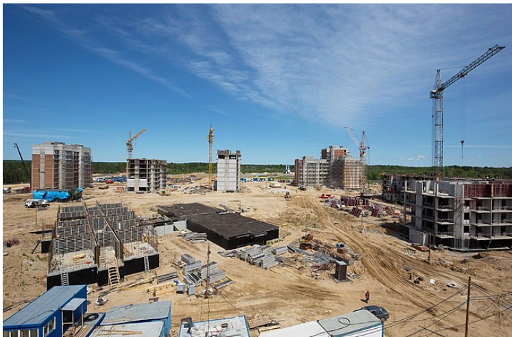
Construction de nouveaux immeubles d'habitation à Tskiolkovsky (2015).
