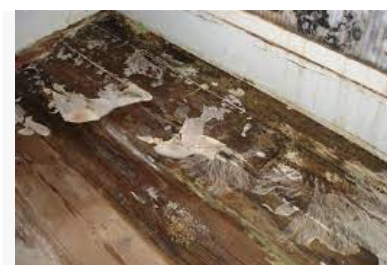
La m\u00e9r\u00e9le dans le bois de mes combles ... revedecomble.fr
