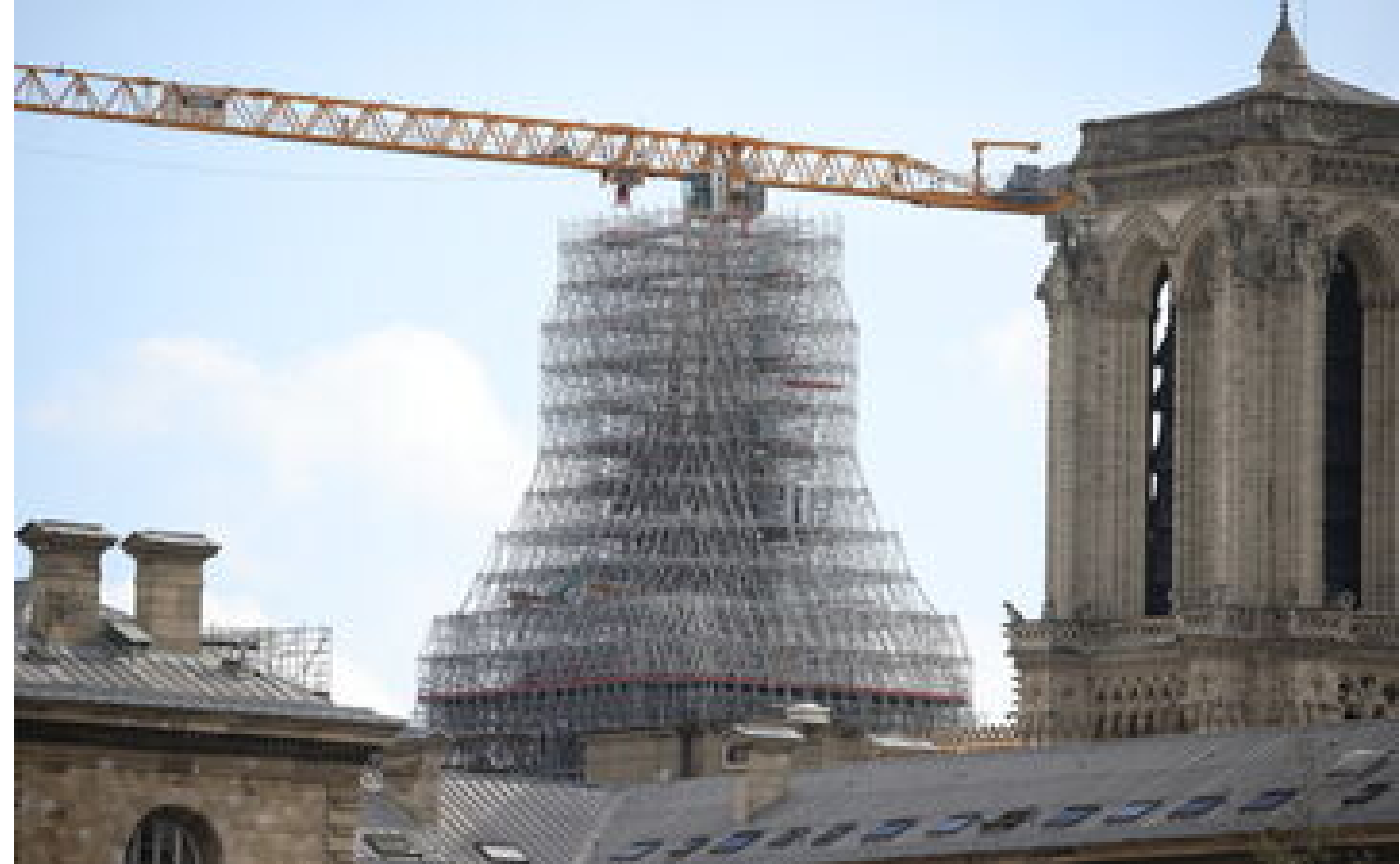
Chantier de Notre-Dame de Paris : la silhouette de la flèche visible dans le ciel « avant Noël »
