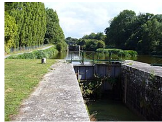
Menguen, écluse n o 166 du canal.
