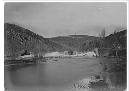
Vue du déversoir n° 119 de Guerlédan - tête de la dérivation de Saint-Samson ; photo prise par J. Duclos entre 1890 et 1895.
