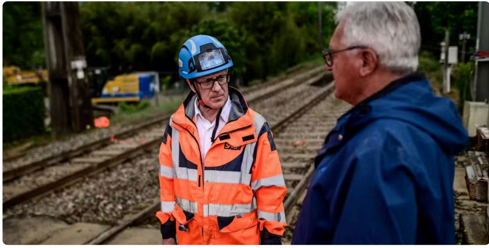
Jean-Luc Gary, directeur régional de SNCF Réseau avait fait le déplacement le 30 avril pour présenter le chantier de réparation de la voie ferroviaire. © Crédit photo : Archives Quentin TOP / SO
