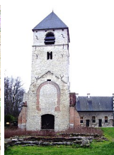
Ancienne tour de Neder-Heembeek.
