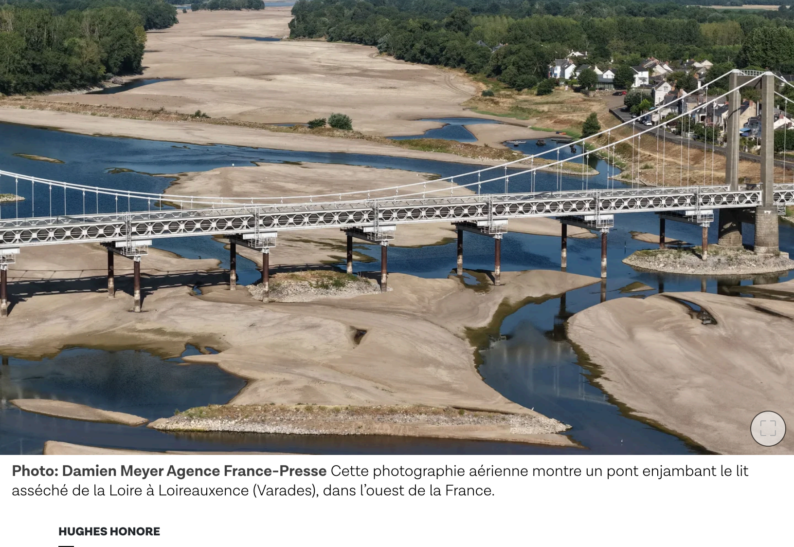
Photo: Damien Meyer Agence France-Presse Cette photographie aérienne montre un pont enjambant le lit asséché de la Loire à Loireauxence (Varades), dans l'ouest de la France.
