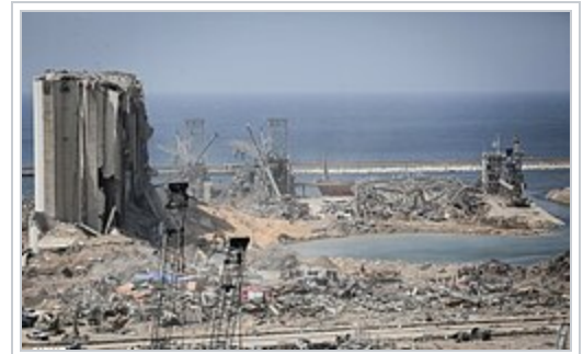
Cratère de l'explosion au port de Beyrouth.
